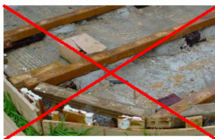
Σεβαστείτε το διάστημα των 10 mm ανάμεσα στα δοκάρια
