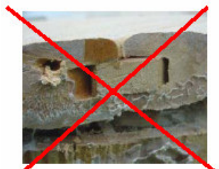
Μη βάζετε σφήνες ανάμεσα στις σανίδες
