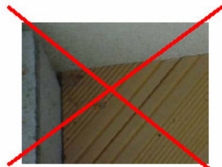
Αφήστε ένα διάστημα 5 mm μεταξύ των σανίδων και 10-15 mm από τον τοίχο
